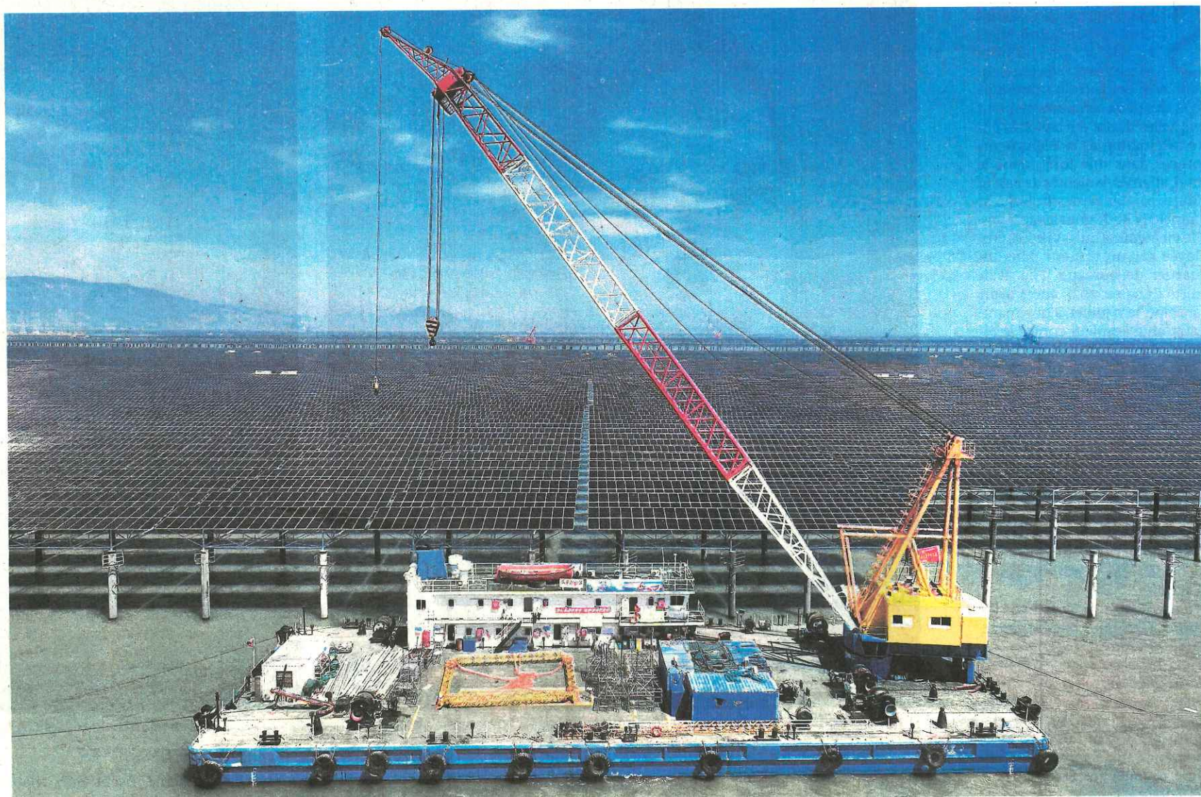
Installation de panneaux solaires en mer, à Lianyungang, dans la province chinoise du Jiangsu, le 19 avril. CN-STR/AFP
